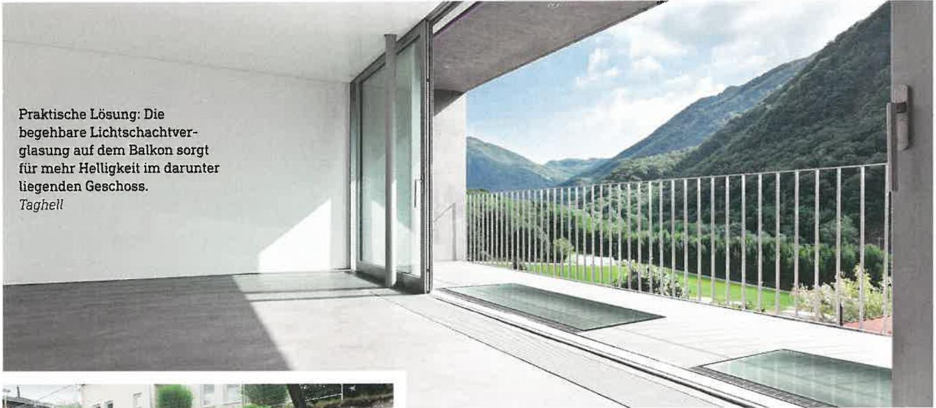
Praktische Lösung: Die begehbare Lichtschachtverglasung auf dem Balkon sorgt für mehr Helligkeit im darunter liegenden Geschoss.
