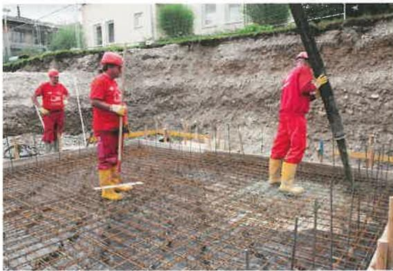
Eine solide Fundamentplatte nimmt die Lasten des Hauses auf und verteilt sie auf ganzer Fläche. *Glatthaar Keller*
